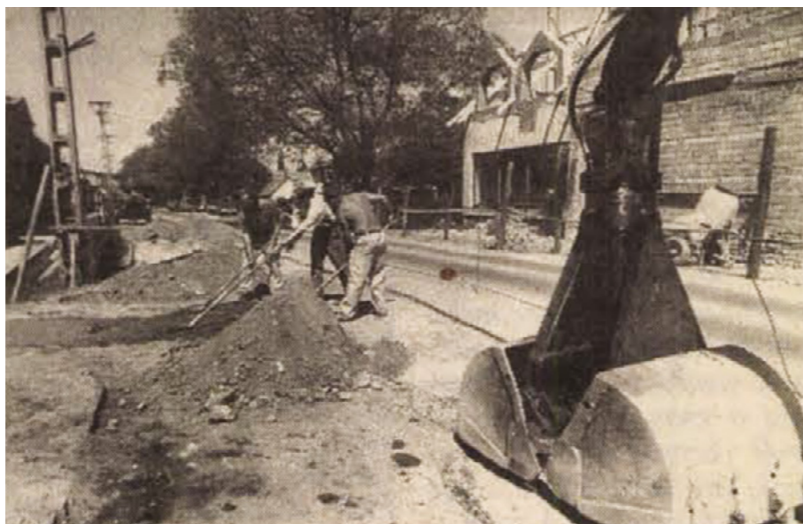
Vezetik a szennyvízcsatornát és a telefonkábelét. Fotó: Pest Megyei Hírlap 1994, Talum Attila
